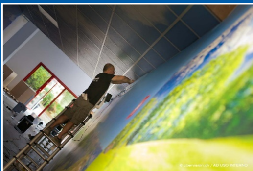
Realizzazione e posa di struttura frame in alluminio più stampa su poliestere con gommino cucito perimetrale. Posa pavimento Evolution 0, rifinitura ramato, performante per luoghi ad alta calpestabilità.
