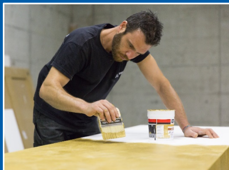
Fase realizzazione e tinteggiatura con pittura decorativa
