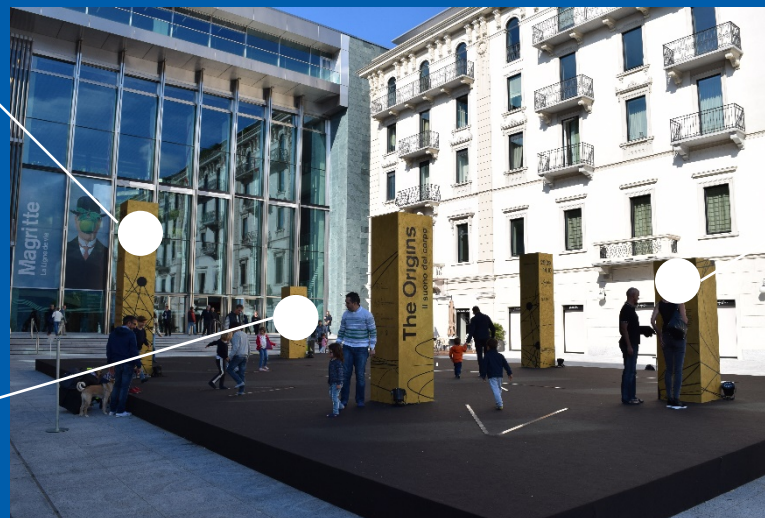
Realizzazione pedana di circa 300m2 con doca e pennelli carply e rivestimento con moquette
